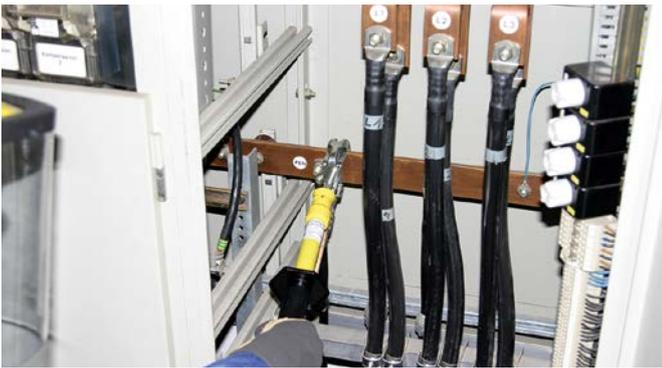
Einbringen einer Erdungs- und KurzschlieÙvorrichtung mit dem Erdungsgriff in einer Niederspannungsschaltanlage.
