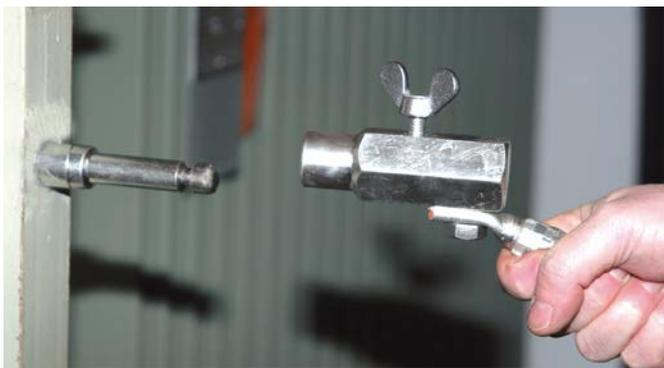
Erdungsfestpunkt mit Ringnut und Erdanschlussbuchse.
