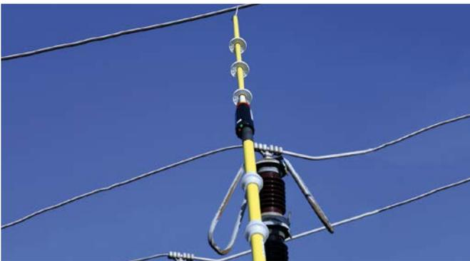
Spannungsprüfer PHE III an einer Freiluftstation 110 kV.
