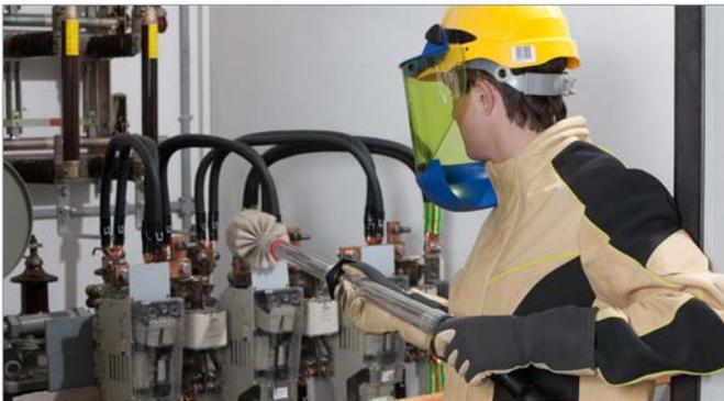
**Reinigen unter Spannung**
