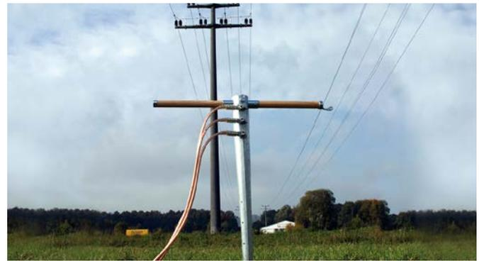
Erdungsrohr mit montierter Erdungsschiene und Erdungsseilen.
