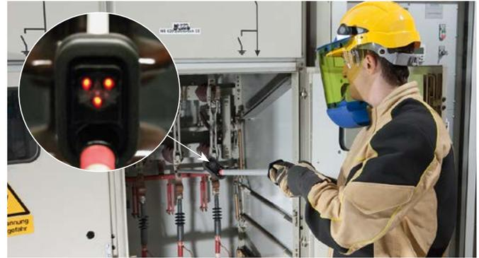
Spannungsprüfer PHG II an einer typgeprüften Schaltanlage.
