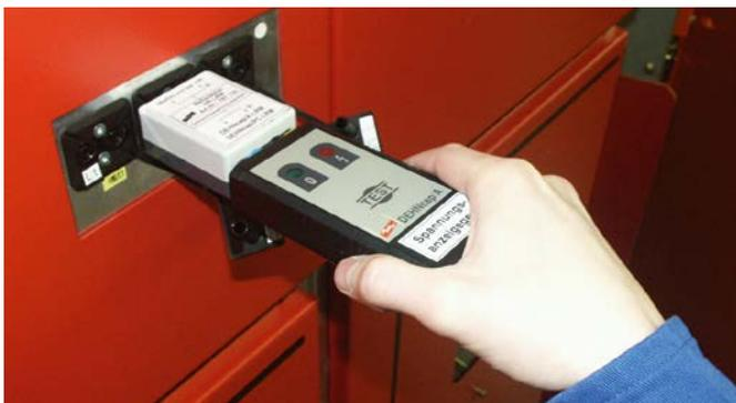
Der HR-LRM Messadapter ermöglicht die Verwendung eines LRM-Anzeigergerätes an einer HR-Messbuchse.
