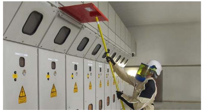
Einbringen einer Schutzplatte der Bauform A3 mit Arbeitsstange.
