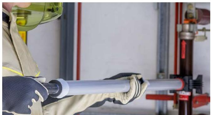
Sicherungszange SZ zum Einsetzen und Herausnehmen von HH-Sicherungen.
