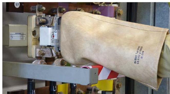
Betätigung einer NH-Sicherung mit NH-Sicherungsaufsteckgriff mit Stulpe.
