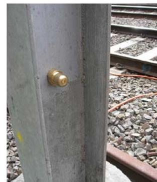
In DIN EN 50122-1 wird für Gleichstrom- und Wechselstrombahnen der Einsatz von Spannungsbegrenzungseinrichtungen für die sogenannte „offene Bahnerdung“ von leitfähigen Bauteilen im Oberleitungs- und Stromabnehmer-Bereich beschrieben.
