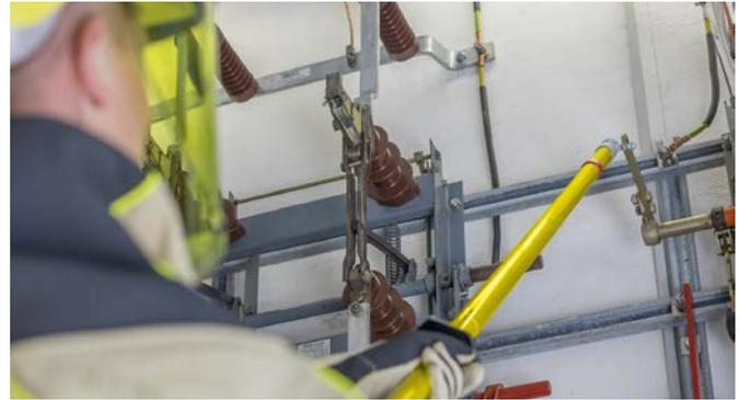
Betätigung eines Lasttrennschalters mit der Schaltstange SCS.
