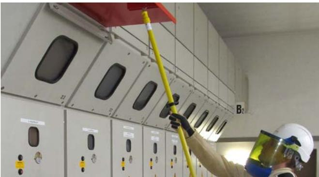
**Ausmessen und Einbauen von isolierenden Schutzplatten**
