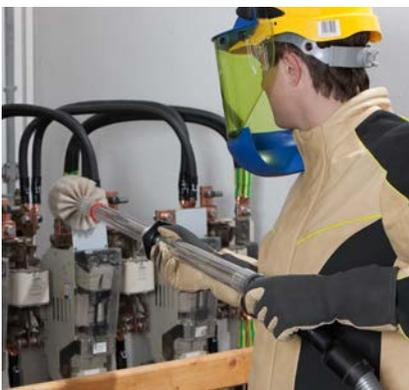
**Arbeiten unter Spannung**
