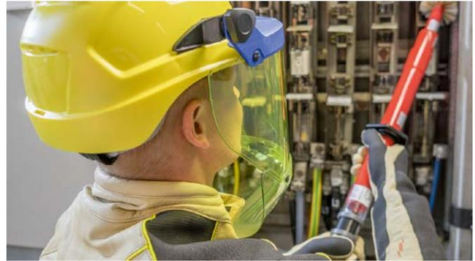
Reinigen einer Niederspannungsschaltanlage mit der notwendigen Schutzausrüstung.
