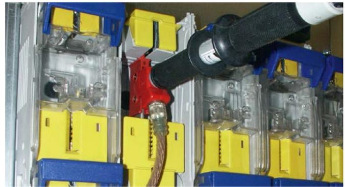
Einsetzen der vollisolierten Erdungs- und Kurzschlieβvorrichtung mit Hilfe des Erdungsgriffes VI.
