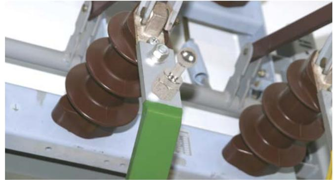
Kugelfestpunkt gerade, montiert auf einer Sammelschiene.
