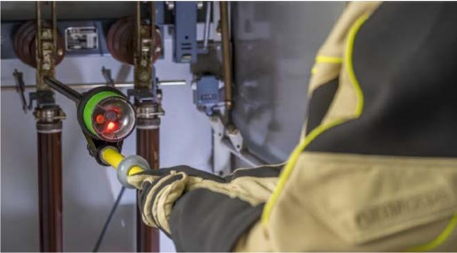
Einpoliger Phasenvergleichler PHV I an einer Schaltanlage.
