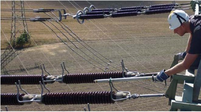
Hochspannungsanzeiger an einer 110 kV-Freileitung.
